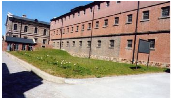
旅順の日露監獄棟の一部
