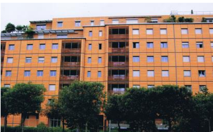
公園から見たマンション 娘さんの部屋は6階です。
