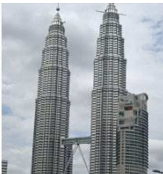
Petronas Twin Towers ペテロナス・ツインタワー
